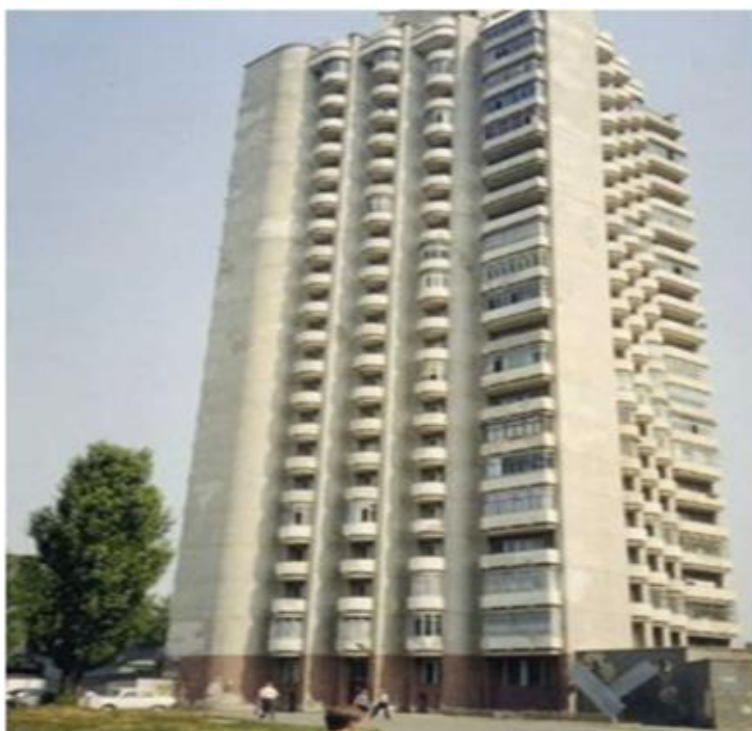
Slika 2. Prva stambena zgrada napravljena od alkalno aktiviranog betona bez OPC-a izgrađena je 1989. godine u Liepcku, Ruska Federacija [33]
